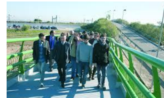
Pasarela a la Escuela Superior de Ingeniería (2019).
