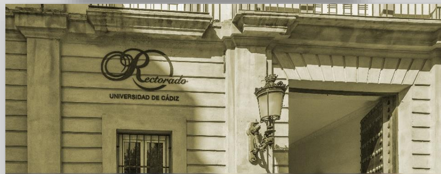
Inauguración de la rehabilitación del edificio Hospital Real (2015) y nueva sede del Rectorado en el Centro Cultural Reina Sofía (2019).
